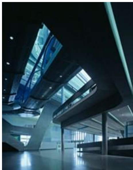
Рисунок 5-Центральное здание завода BMW Лейпциг, Германия (2001 - 2005)
